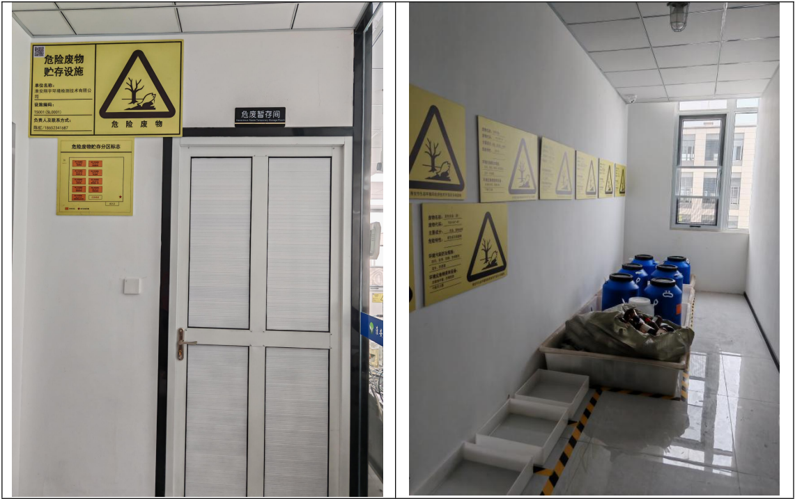
图 4.1.4-1 危废暂存间建设情况
