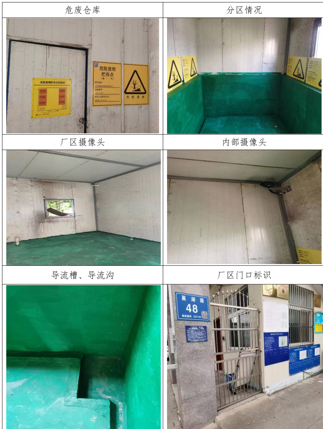
图 4.1-3 危废仓库建设情况
