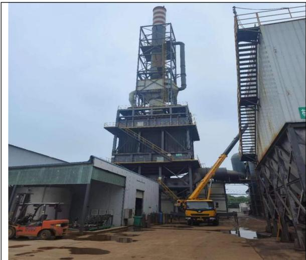
1#排气筒处理设施（双碱法脱硫+湿电除尘）
