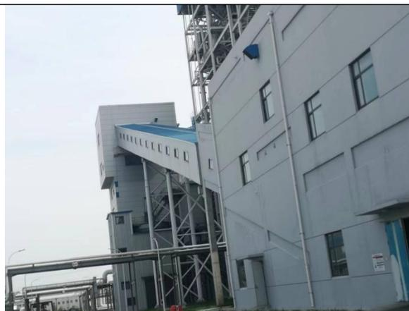
输煤系统（皮带机采取封闭措施）
