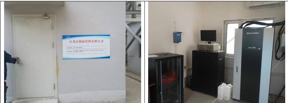
图 4.2-3 废气在线监测
