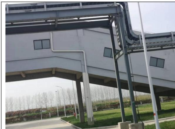
输煤系统（皮带机采取封闭措施）
