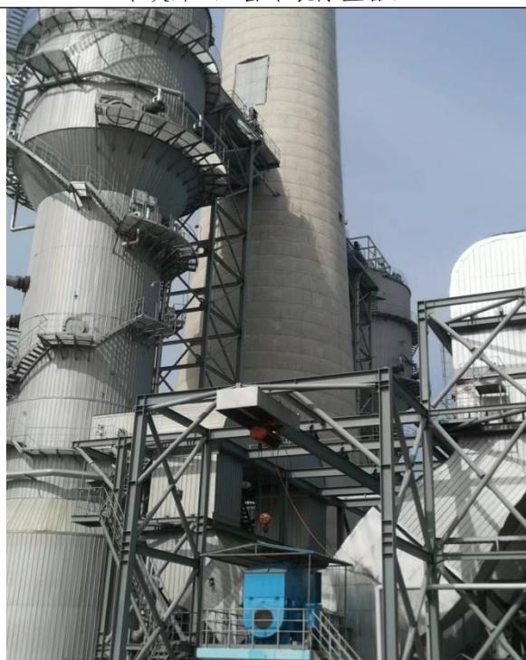
1#、2#锅炉 (脱硫装置+湿式电除尘器)
