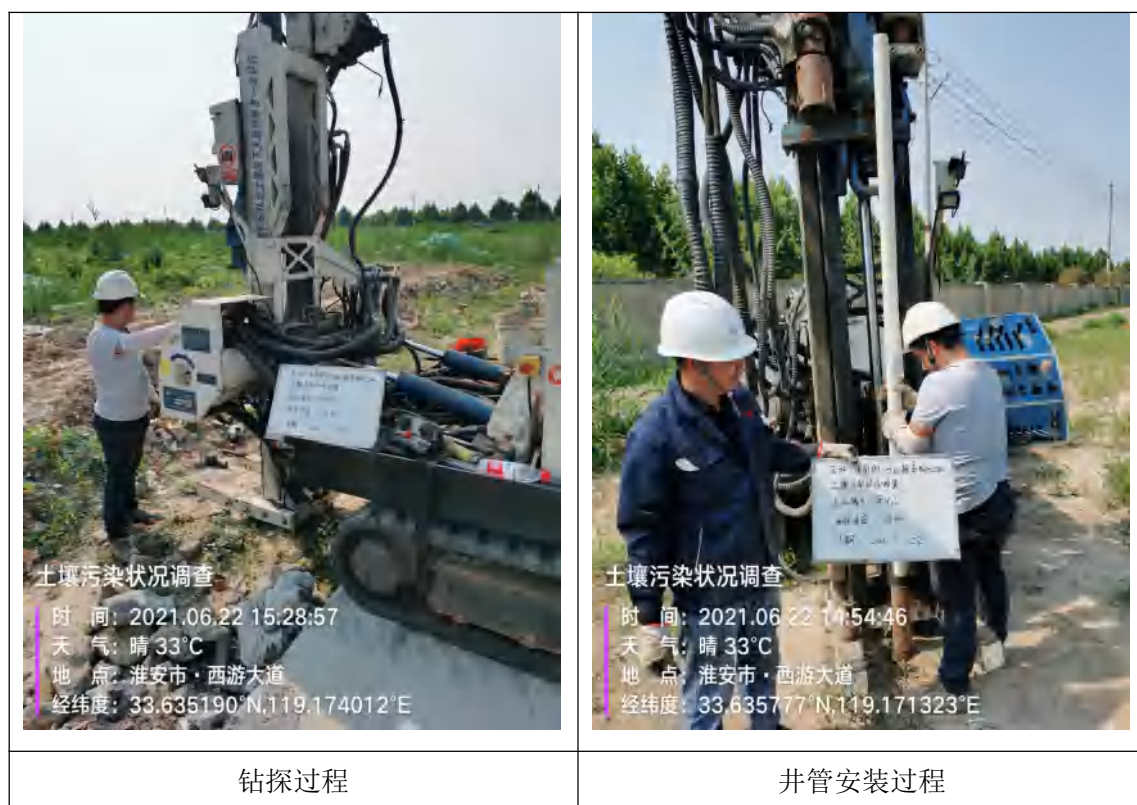
图 4.3-2 监测井建井照片
