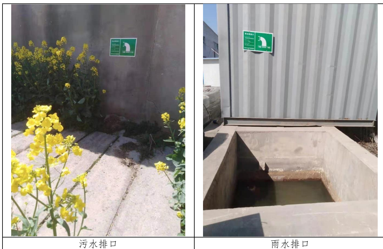
图 4.2-2 排放口规范化设置现场图片
