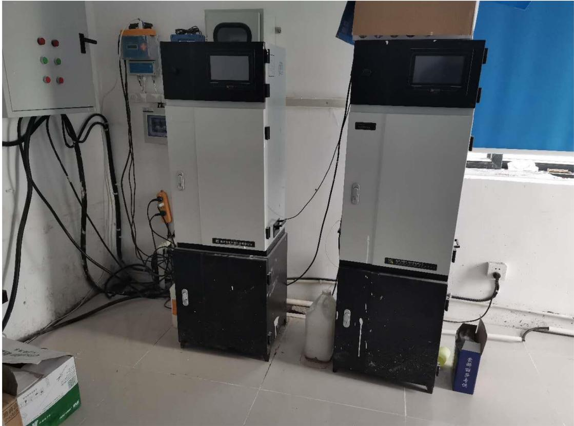
图 4.2-3 废水在线监测设备
