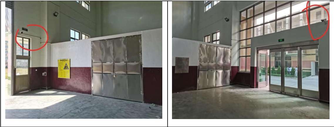
图 4.1-6 危废暂存场所摄像头
