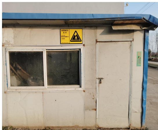
图 4.1-4 项目固体废物暂存场所
