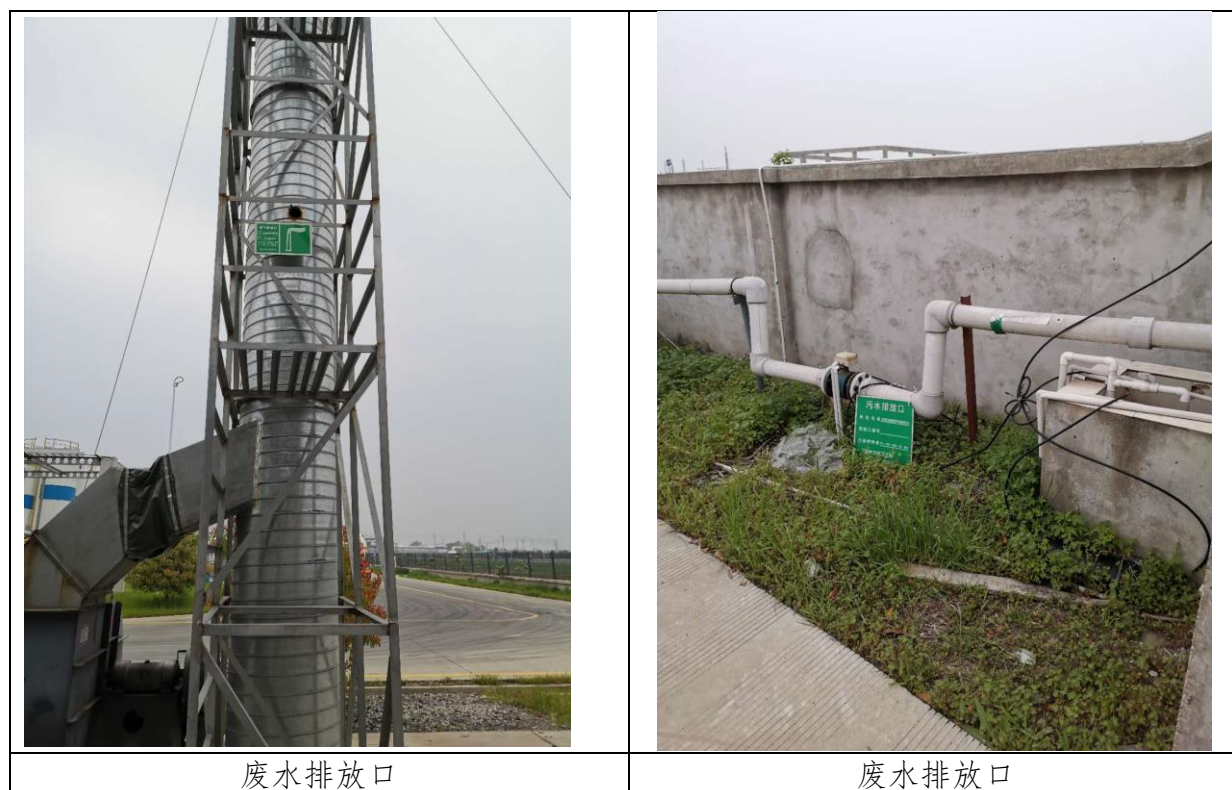
图 4.2-3 排污口现场照片
